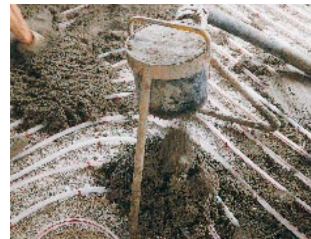
... sable et gravillons jusqu'à une granulométrie de 16 mm (p. ex. dans le cas d'une forme d'égalisation isolante avec de l'argile expansée).
